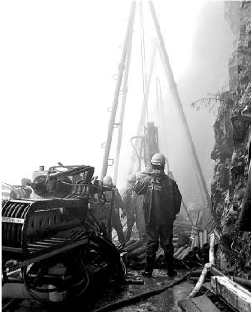
九日，救援人員在武隆雞尾山懸崖旁鑽孔，目的是打通山體中的礦井，向其中輸送空氣和營養液，救援被困礦工。（新華社）
