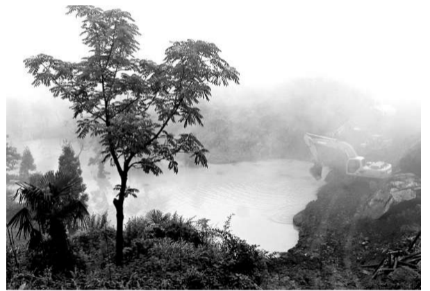
近三日的持續降雨使武隆山體垮塌現場的雞尾山堰塞湖容積急劇增加。圖為九日，挖掘機在堰塞湖的下游修築碎石壩防止水滲透至礦井。（新華社）
