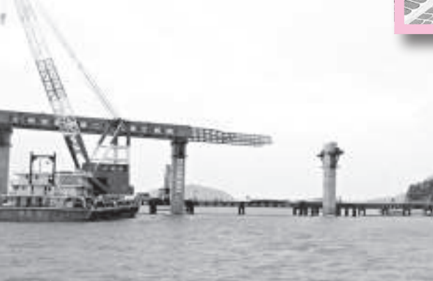
平潭海峽大橋已開始鋪設橋面（本報攝）
