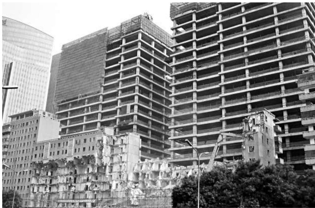
北京一建築拆遷現場
