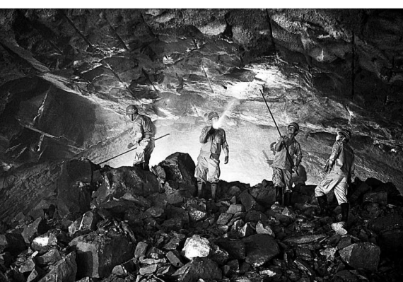
廈門翔安海底隧道右線隧道十三日貫通，隧道洞門炸開後，建設者對頂部進行安全檢查（新華社）
