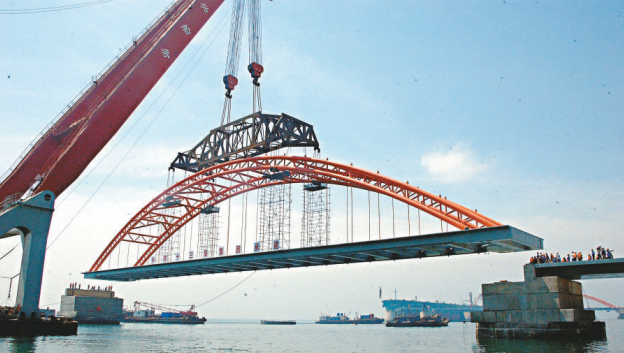
國內原油碼頭建設中使用的最大跨度的海上引橋吊裝完成
