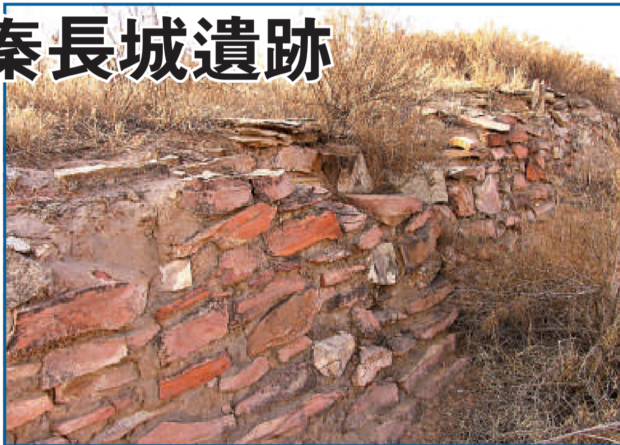
神木縣大柳塔鎮境內，勃牛川西岸的秦長城，用塊石包砌 (喬建軍供圖)
