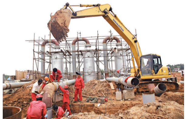
川氣東送工程安徽省境內管道線路全長 447.9 公里，其中郎溪段總長 55.9 公里，郎溪段所有工程預計在 8 月底竣工。圖為工程施工現場，工人正在加緊施工 (新華社)
