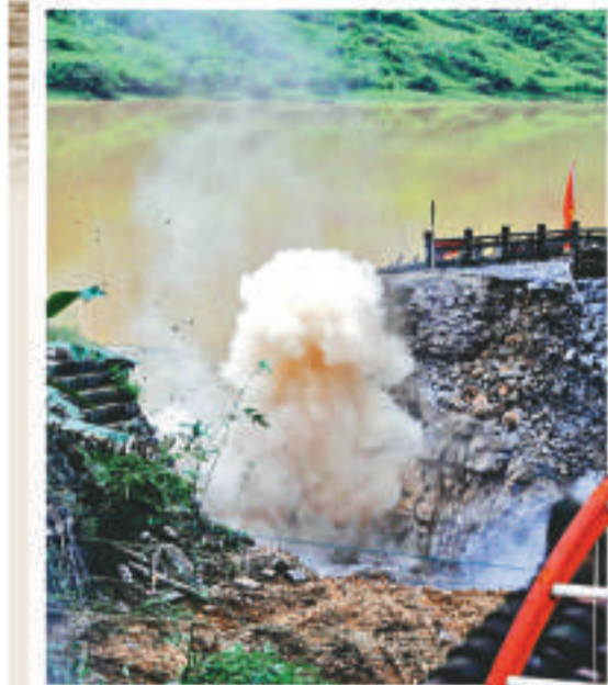
施工隊在卡馬水庫右側大壩切割處實施爆破（新華社）
