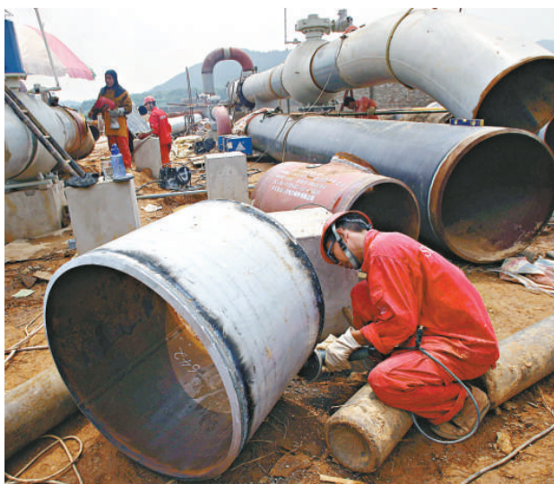
四川災後經濟勢頭良好。圖為川氣東送工程安徽郎溪段施工現場（資料圖片）
