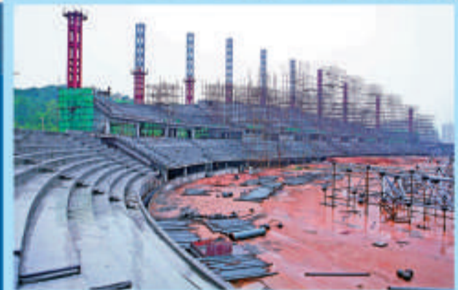
▲深圳大運會新建場館進入鋼結構施工
