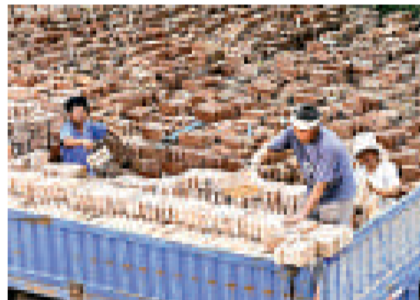
智障人士被拐騙到磚窯廠做黑工，每天勞動十多個鐘卻薪水免問（網絡圖片）
