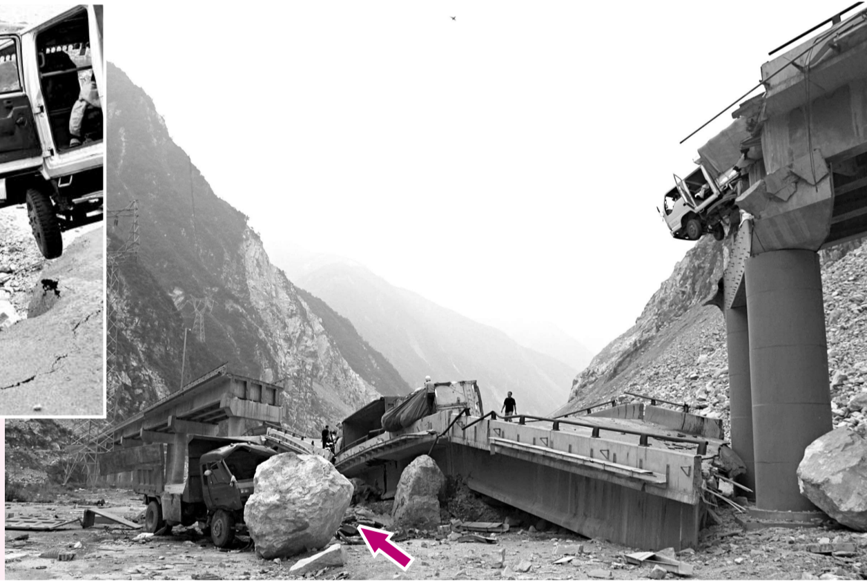
▲由於連日大雨衝擊，國道213線四川汶川段徹底斷橋被巨石(箭頭)砸斷，造成橋面毀毀，造成6死12傷慘劇。圖為從上下角度拍攝飛石砸毀汶川徹底斷橋的現場 (新華社)
