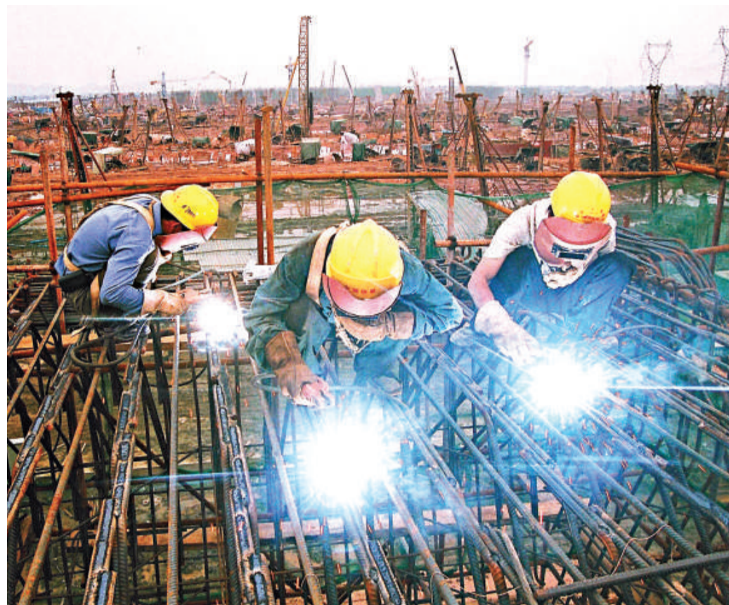
▲目前包括廣深港高鐵在內的珠三角城軌網建設進展順利。圖為工人開工現場 (本報攝)
