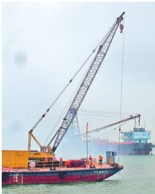
▲大橋環評報告建議各工程分商應實施嚴格的清潔生產措施，嚴防施工機械和船舶的油料洩漏，避免對水體造成污染（本報攝）
