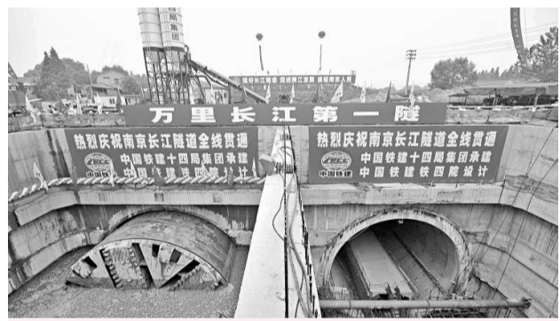
二十二日，南京長江隧道全線貫通。畫面左側是當日貫通的右線隧道，畫面右側是五月二十日貫通的左線隧道洞口 (新華社)
