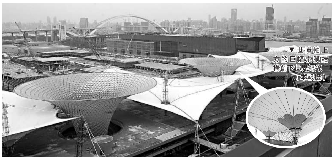
▲8月30日，世博園區世博軸膜結構工程全面完工，這是其工程局部（新華社）
