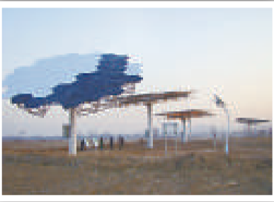
▲定日鏡是塔式太陽能發電電站的關鍵部件之一 ▼中科院電工所研製的多碟式聚光器
