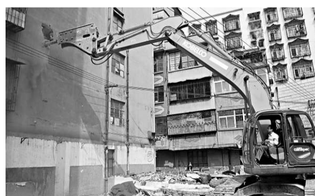
隨著拆遷工程的展開，昆明南市區中央商務區建設正式啟動 (本報攝)
