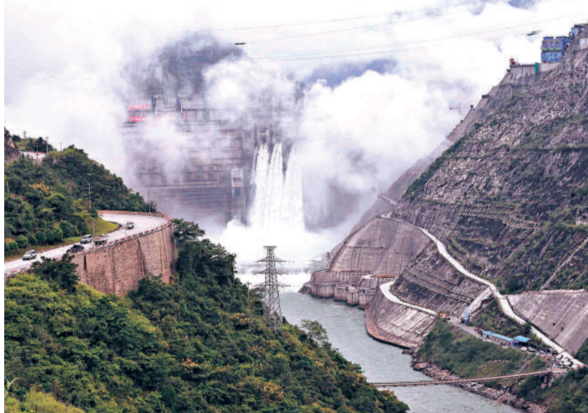
位於雲南省南澗縣與鳳慶縣交界的澗澗江中游河段上的小灣水電站首台機組昨日成功併網，正式投產發電。該電站是國家重點工程和西部大開發「西電東送」標誌性戰略工程，總裝機容量420萬千瓦，單機容量70萬千瓦（新華社）
