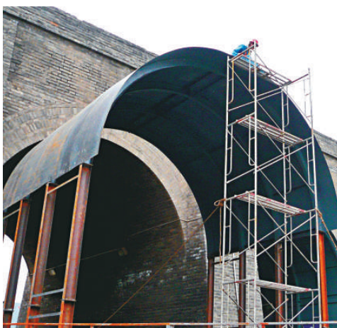
西安地鐵二號線用型鋼支撐城牆門洞拱作為保護（本報攝）
