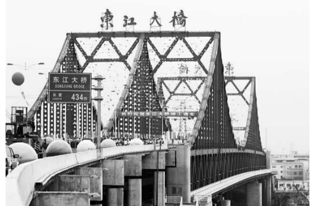
東江大橋竣工通車儀式（黃仰鵬攝）
