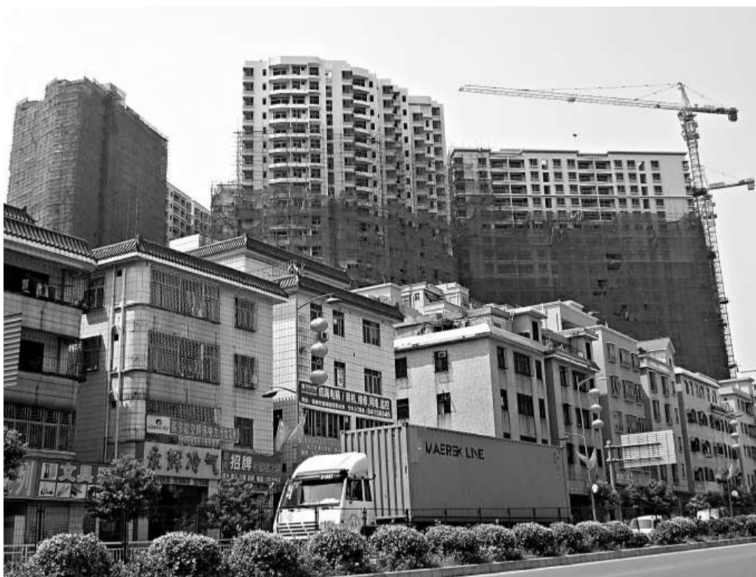
▲正在興建中有集資房，與周邊農民房相比有較大提升 (王一梅攝)
