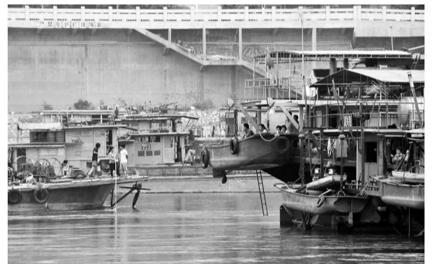
▲飛來峽水利樞紐放水後，北江河道清遠段受堵的船舶得以緩緩前行 (新華社)
