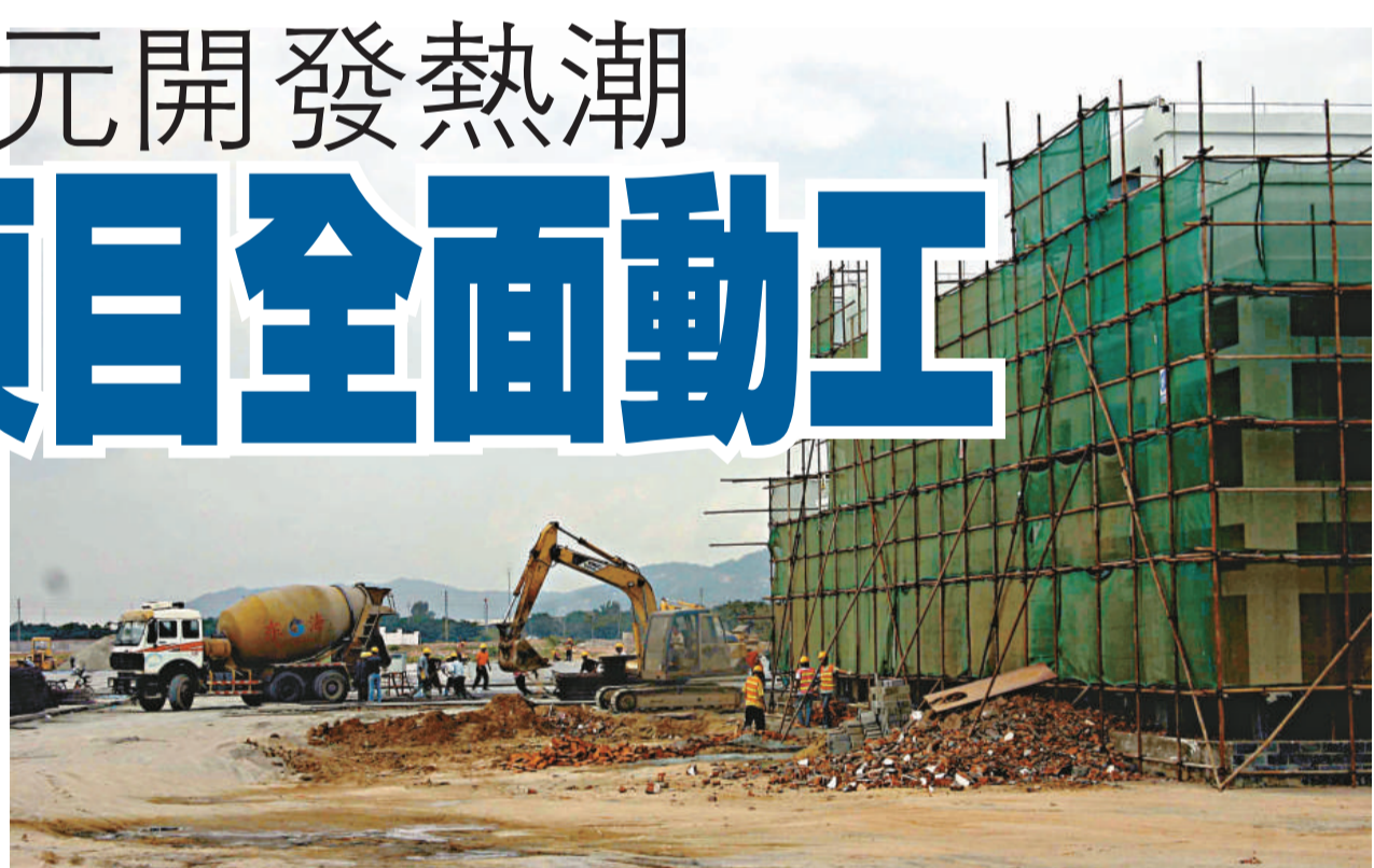
澳門大學橫琴校區目前進入建設用地平整階段，建設指揮部大樓已現雛形（本報攝）
