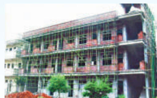
▲河源市黃田鎮久社中心學校善苗之星林東教學樓工程進展
