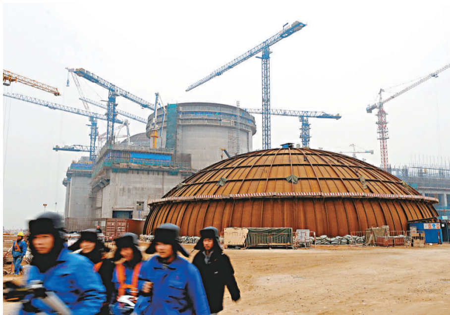
遼寧紅沿河核電站一期工程開工兩年多來，主要設備的國產化配套與技術創新等都取得了重要進展 (新華社)
