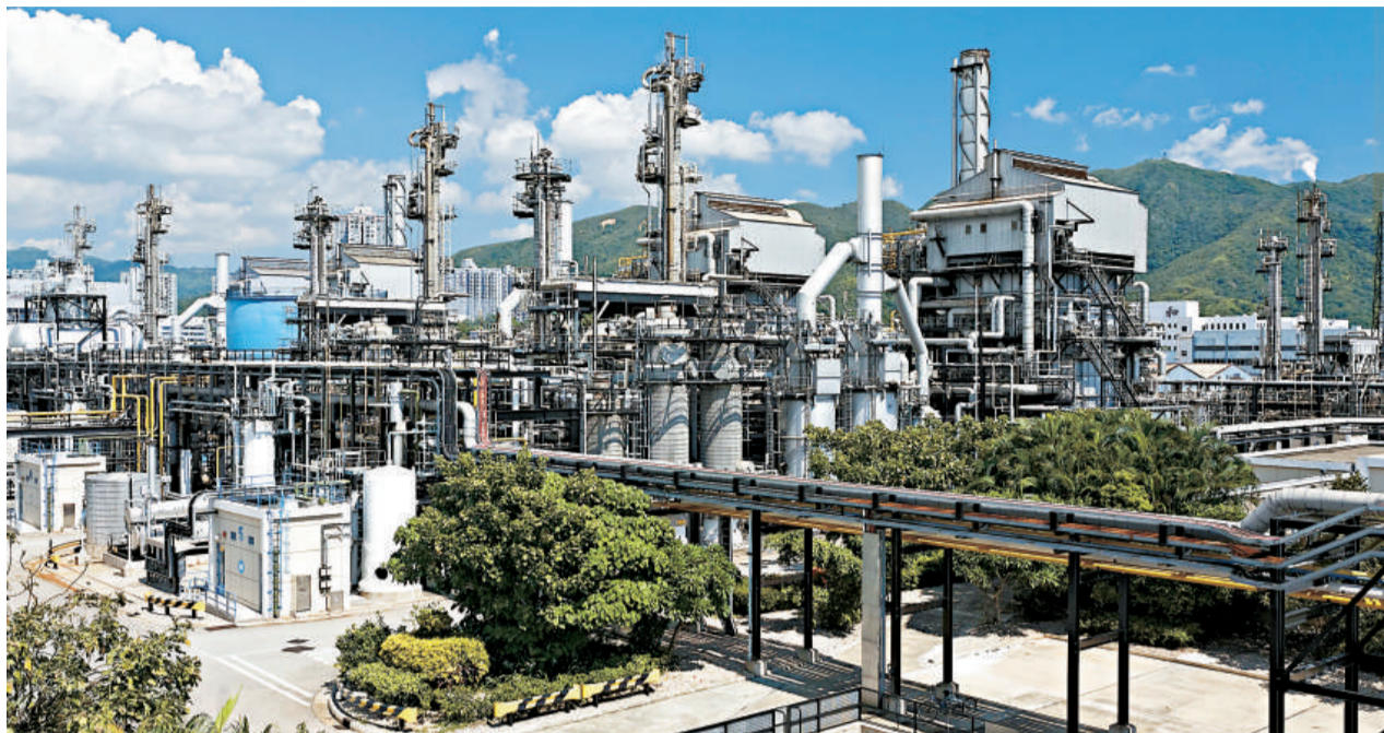
煤氣公司現時主要透過大埔廠房及馬頭角廠房，向全港 160 萬個用戶供應煤氣。圖為煤氣公司廠房相片
