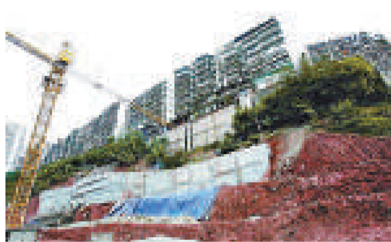
樓裂事件發生於重慶市奉節縣中心區最繁華的地帶，圖片可見居民樓地基被挖成峭壁 (互聯網)
