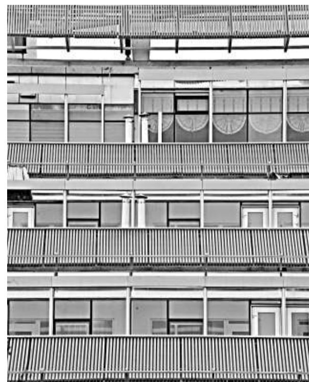
太陽能建築日月壇，微排大廈在山東德州啓用。這座太陽能大樓是按照綠色「雙五星」（綠色五星/國際五星）標準建造的太陽能主題酒店，同時也是世界上最大的集太陽能光熱、光伏、建築節能於一體的高層公共建築。圖為日月壇，微排大廈頂部與建築融為一體太陽能集熱、發電設備（新華社）
