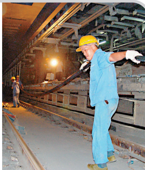
▲今年11月前廣州將新開通六條地鐵線，工人正在加緊施工 (方俊明攝)
