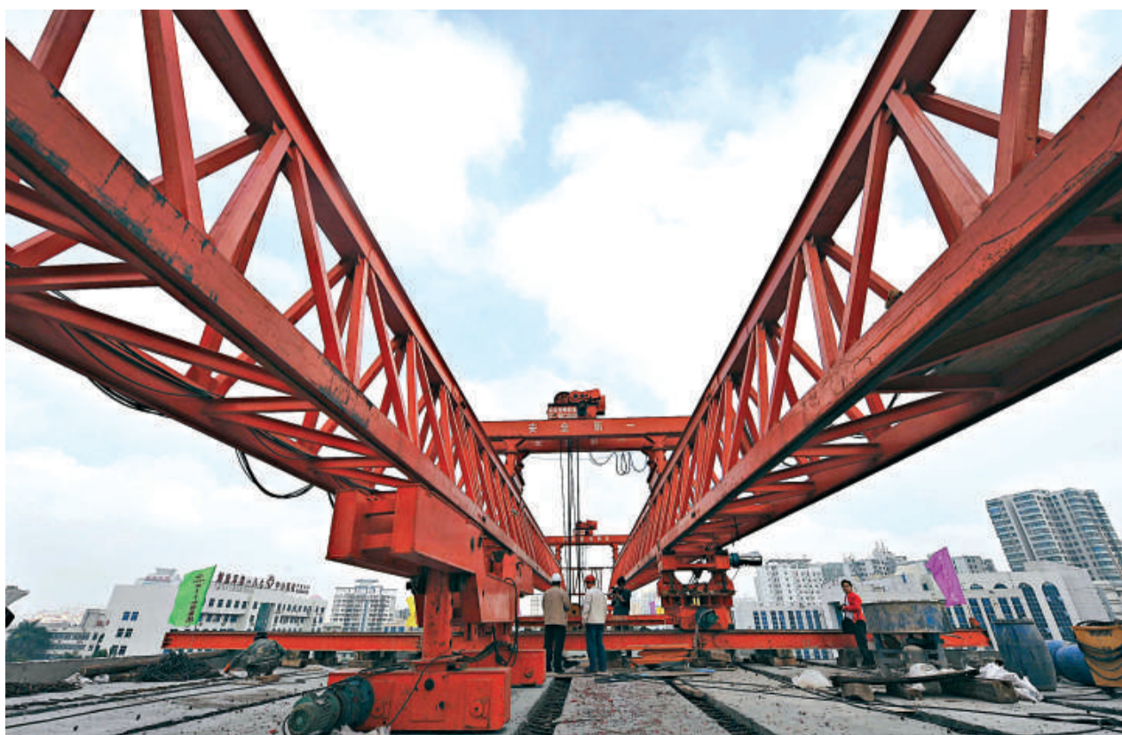
十八日，海南東環鐵路海口東站與東環鐵路海口雙線特大橋合龍。至此，全長近二十二公里的東環鐵路海口雙線特大橋全線架通。這是東環鐵路海口雙線特大橋上的一部架橋機 (新華社)
