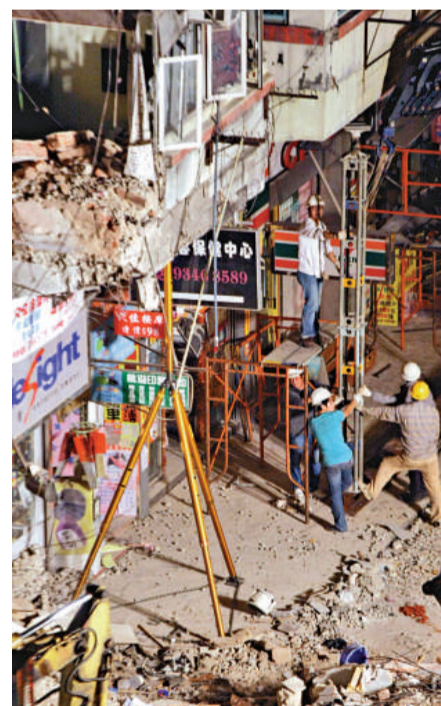
▲當局漏夜在肇事唐樓附近的大廈進行簡單的加固工程 (黃洋港攝)
