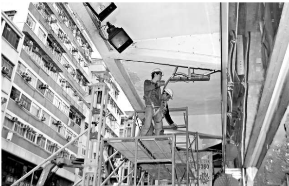
工人繼續進行加固工程，安裝支架托住受影響唐樓的底部，以免出現傾斜倒塌（本報攝）
