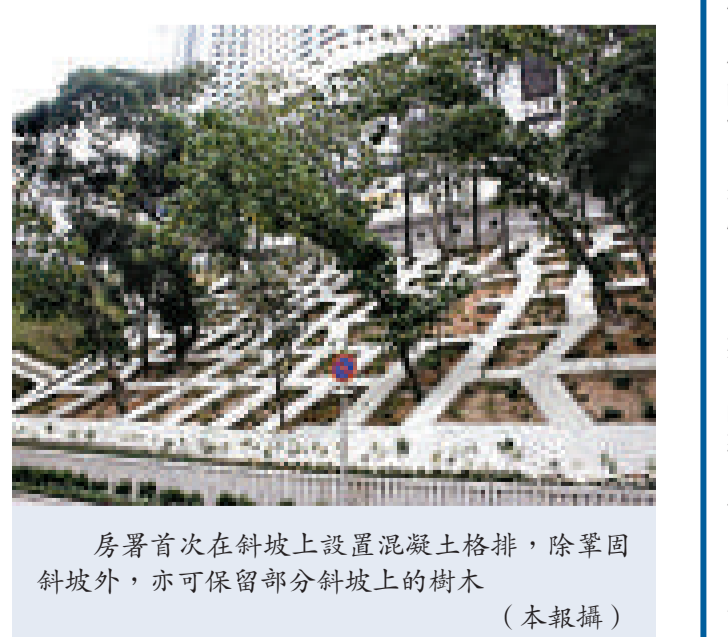
房屋首次在斜坡上設置混凝土格排，除鞏固斜坡外，亦可保留部分斜坡上的樹木 (本報攝)
