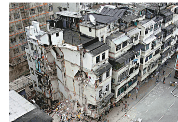
▲今年一月底，馬頭圍道唐樓倒塌場景
