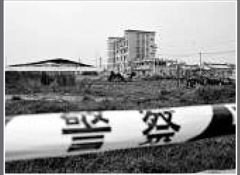
石橋頭村楊俊樹家的兩棟六層高獨立樓被炸成危樓 (本報記者 蔡鍾龍攝)
