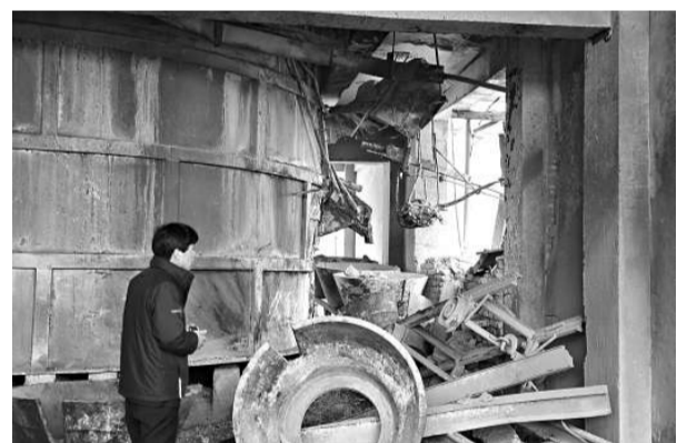
26日凌晨，陝西省永壽縣正在生產中的永壽金獅電化廠電石冷卻鍋突然翻側，高溫電石液體與潮濕地面發生反應後閃爆，導致現場作業的13名工人被燒傷。圖為工作人員27日在查看事故現場。(新華社)
