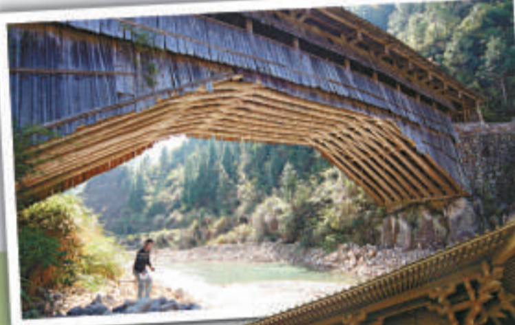
◀赤溪廊橋坐落在福建政和縣澄源鄉赤溪村（李隆智攝）
