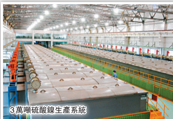
國內有色冶金最大的選礦磨浮生產線——每日14000噸選礦磨浮生產線（柯玉棟攝）
