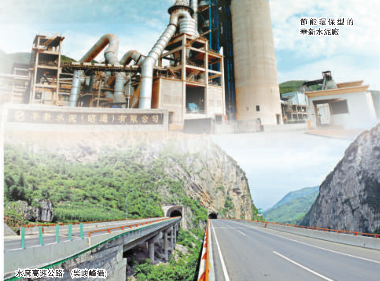
水麻高速公路(崇峻峰橋)
