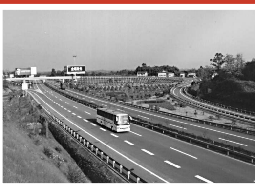
貫穿全境的滬蓉高速公路墊江下道立交
