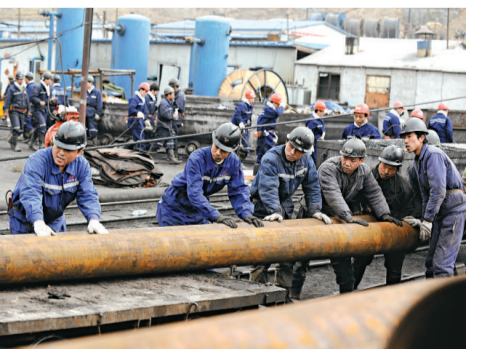
30日，山西礦難救援人員往井下運送排水管道 (新華社)
