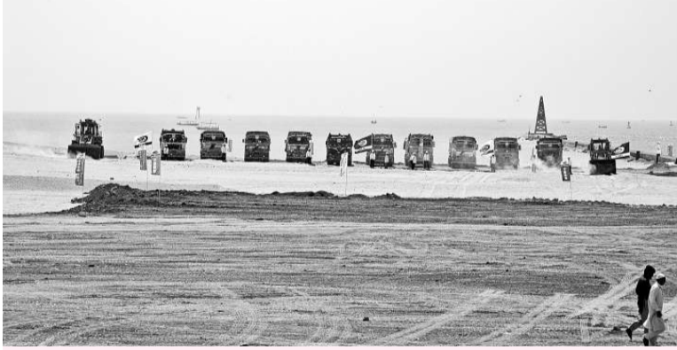
卡拉奇深水港填海工程已進入平整土地
