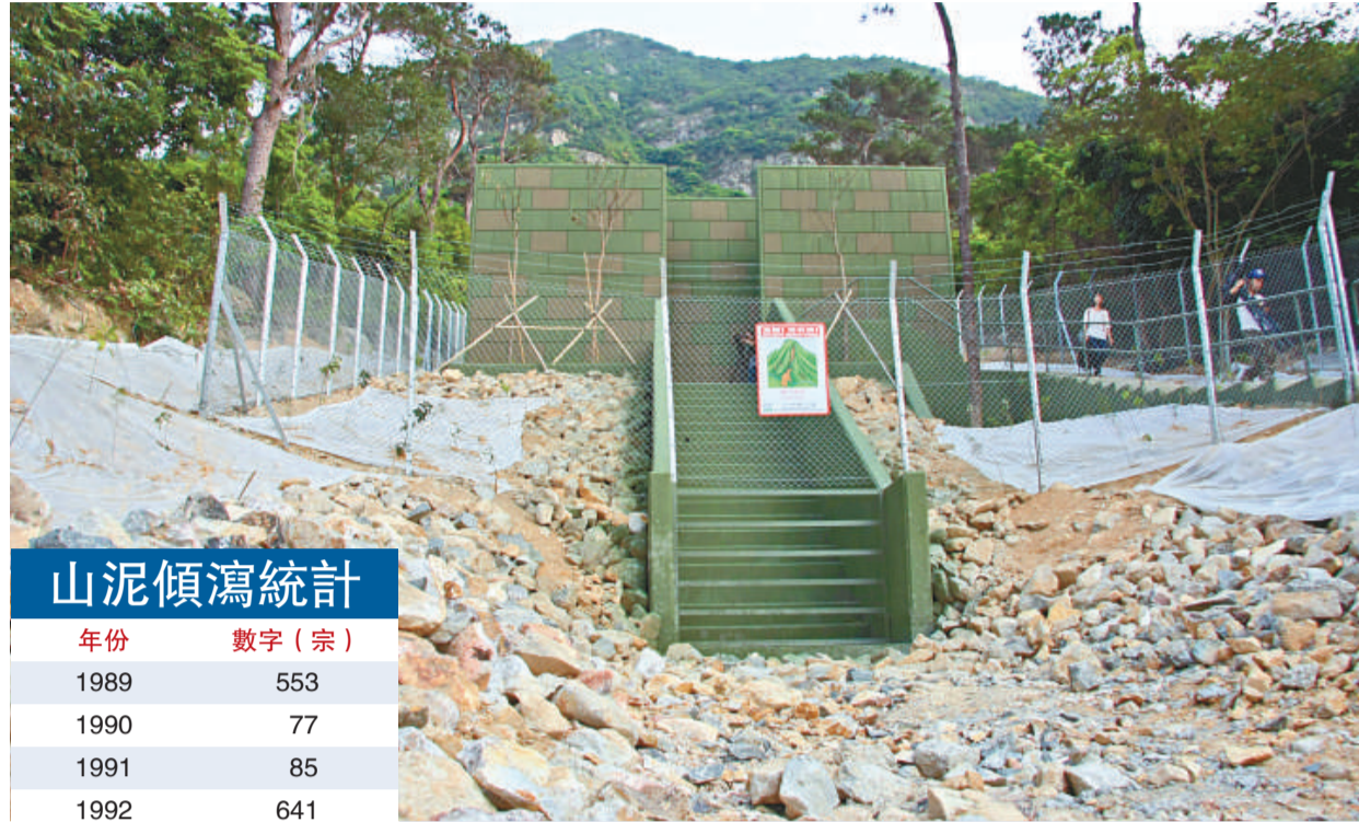
圖中綠色的建築物為大澳南涌的泥石壩，其前方貼有署方新製的警告牌；前面的大石製成一條坑，供山泥傾瀉時的雨水流向下面的平地（本報攝）
