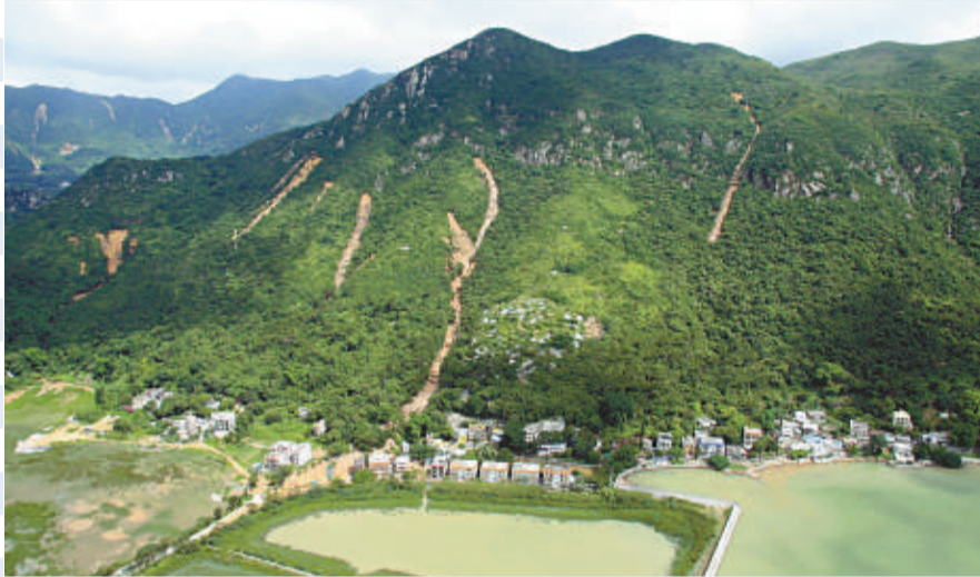
08年6月大澳南涌村發生山泥傾瀉後的俯瞰圖（土木工程拓展署提供）
