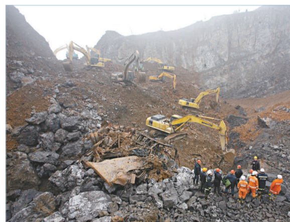
4月11日，四川省峨眉山市順江採石場山體垮塌事故救援工作進入第5天，救援人員在一號救援通道前發現4台被埋汽車殘骸，但仍未發現14名被埋人員 (新華社)
