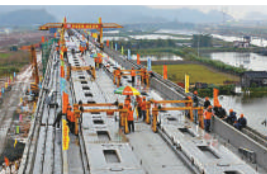
廣深港高鐵的無砟軌道施工的先導段順利通過國家鐵道部評審（本報攝）
