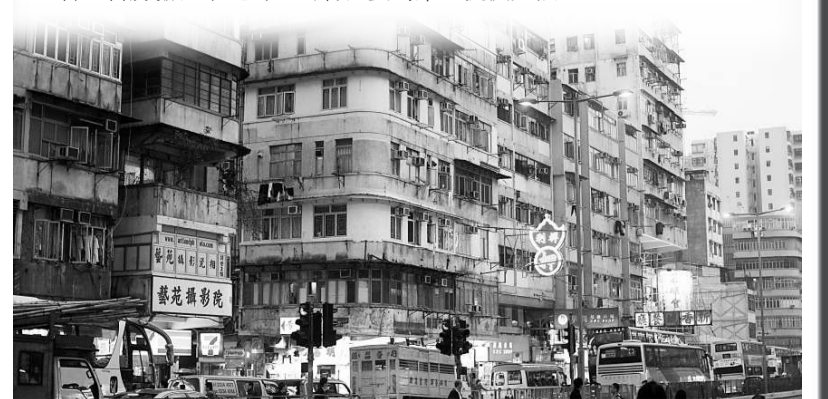
▲當局已完成逾四千幢舊樓的巡查，發現逾四分之一明顯欠妥
