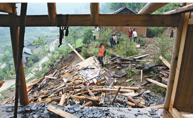
▲特大暴雨給湖南省新化縣造成山體滑坡、泥石流和崩塌達6400餘處，30多人受傷，損失3.2億 中新社
