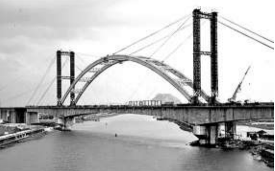
位於番禺的高鐵驕陽涌大橋早前順利合龍，為目前中國高鐵最大跨度連續拱橋 本報攝
