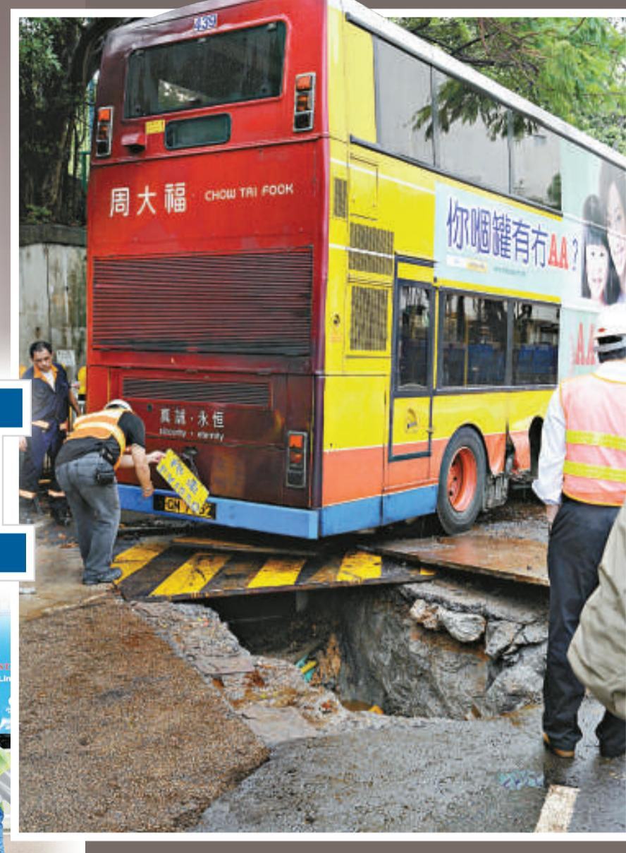
▲肇事地盤掘有約十米乘五米、深約兩米坑洞，坑面用三塊鋼板鋪着
