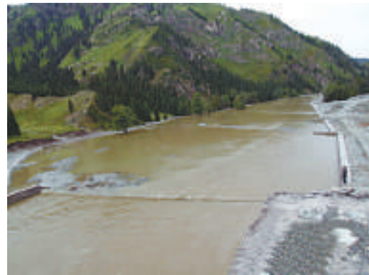
▲在已經建好的主溝大壩上，經過大小壩的層層阻攔，到入湖口的河水明顯清澈了許多，泥沙被阻攔了
